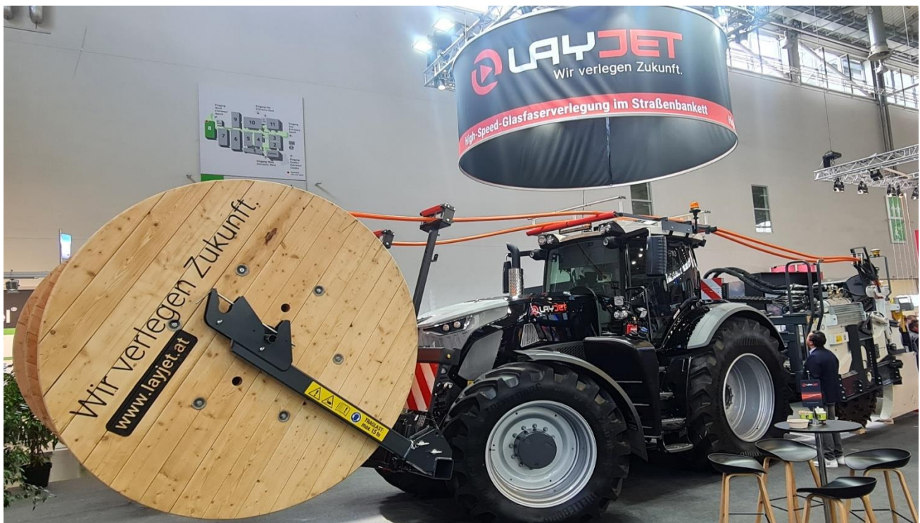
High-Speed- Fibergraben und Verlegung, alles in einem einzigen Vorgang
